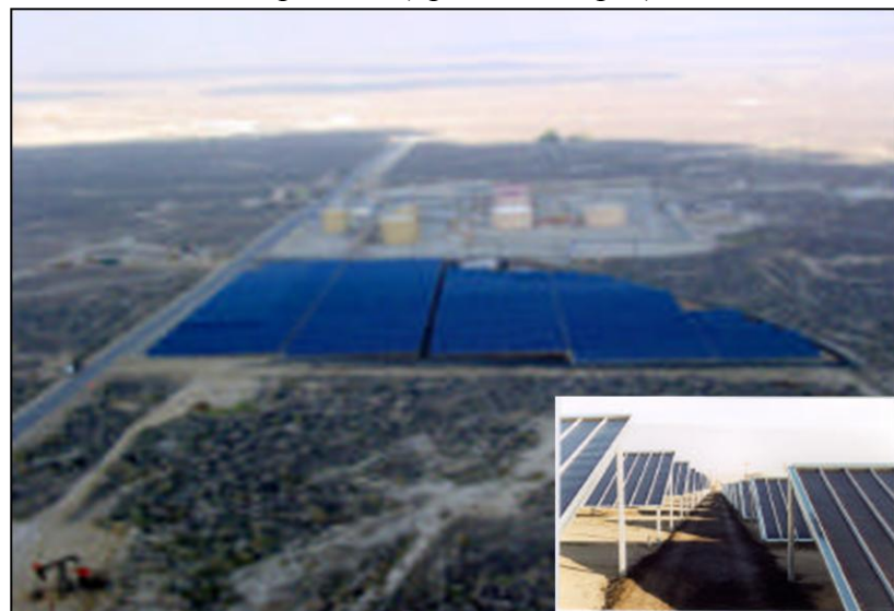
Рис. 2.26. Фотоэлектрическая станция на a-Si:H в Калифорнии, США (4800 модулей размером 5.4 \times 0.4 \text{ м}^2 , 0,5 МВт).
