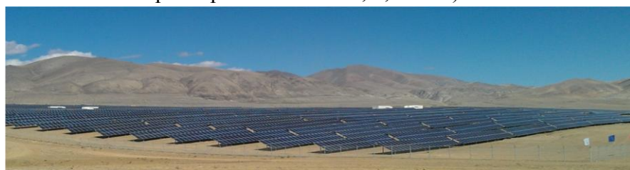
Рис. 2.26. Фотоэлектрическая станция на a-Si:H в Калифорнии, США (4800 модулей размером 5.4 \times 0.4 \text{ м}^2 , 0,5 МВт).
