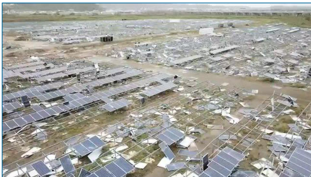
Рисунок 65. Разрушение солнечной фермы в Пуэрто-Рико.
