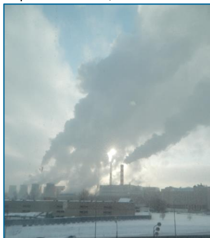
Рисунок 56. ТЭЦ-20 ПАО «Мосэнерго», г. Москва.
