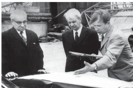
Академики В.А. Котельников, М.Л. Келдыш, А.Ф. Богомолов на полигоне «Медвежье озеро» обсуждают ход строительства антенны ТНА-1500
