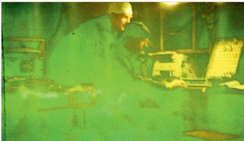
Щит дозконтроля на ЧАЭС. Пленка засвечена в условиях высоких радиационных полей (фото из архива Геннадия Решетникова - ОИЯИ г. Дубна)
