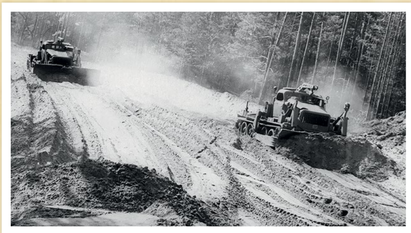
Операции дезактивации грунта и просёлочных дорог в зоне отчуждения
