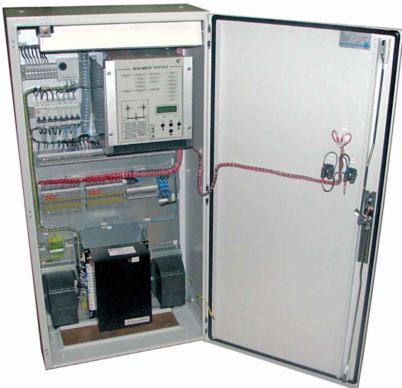
Шкаф управления устройства быстродействующего автоматического включения резервного питания (БАВР) разработки кафедры ЭПП
