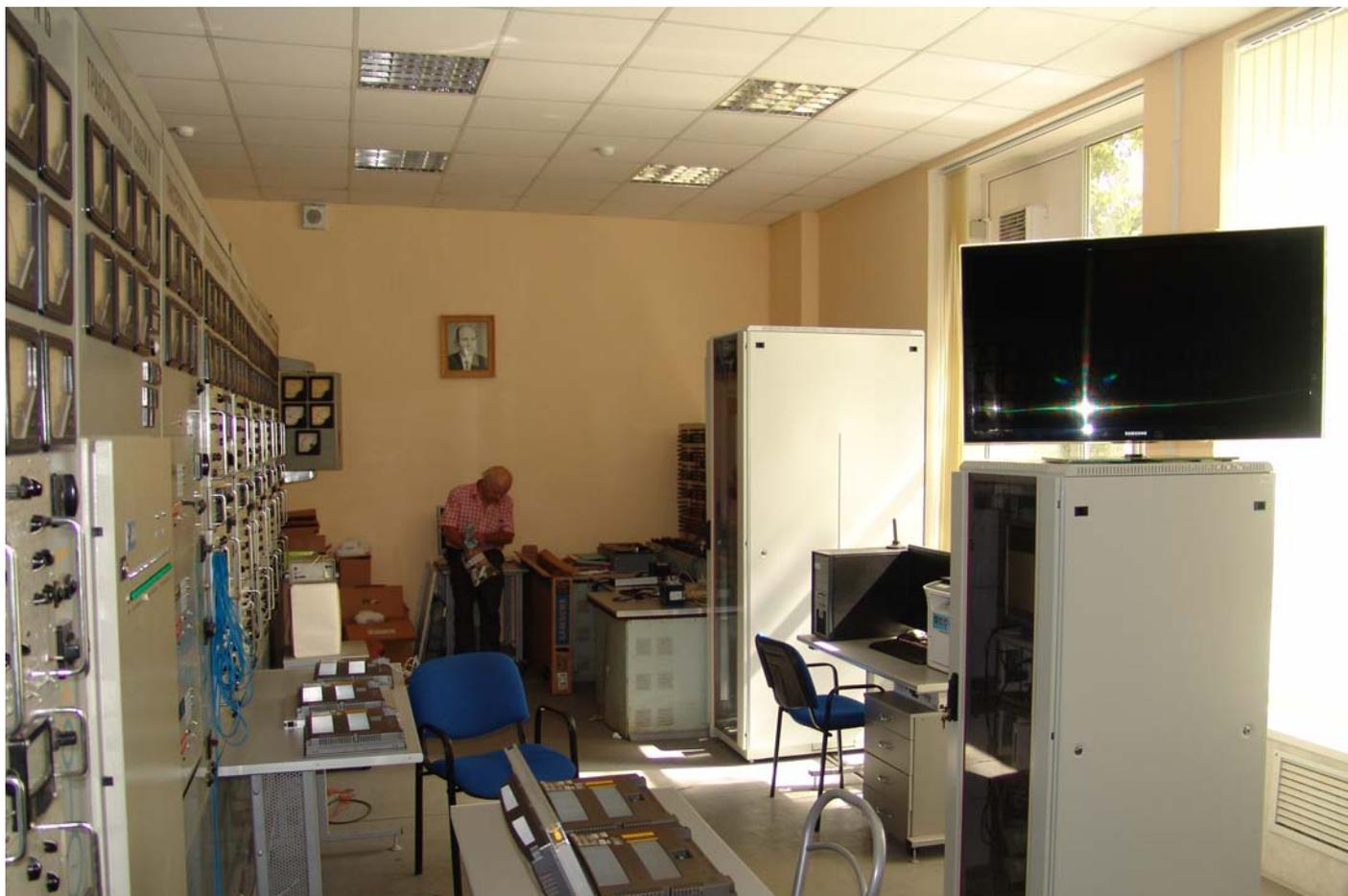
**Электродинамическая модель электроэнергетической системы, позволяет проводить испытания новых объектов электроэнергетики, создавать и корректировать математические модели электроэнергетических систем**
