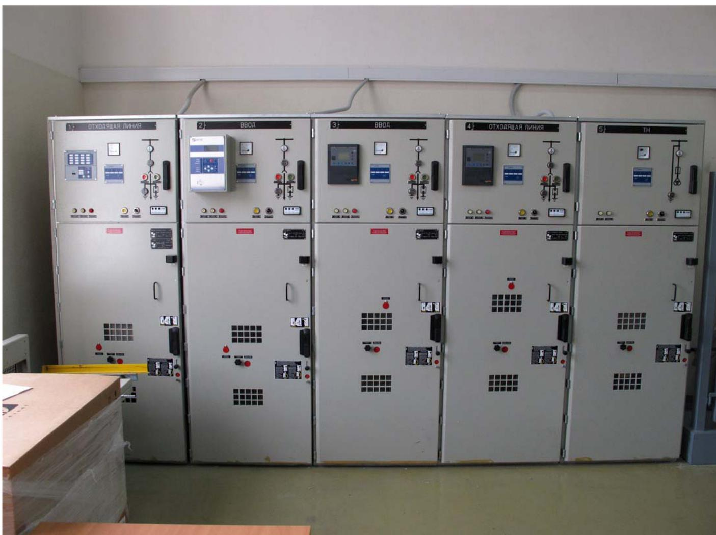
Комплектное распределительное устройство 10 килоВольт учебно-исследовательского испытательного центра кафедры "Электрические станции". Ячейки с вакуумными выключателями, микропроцессорными защитами и средствами дистанционного мониторинга через интернет. Используется при проведении учебных и научных экспериментальных работ.
