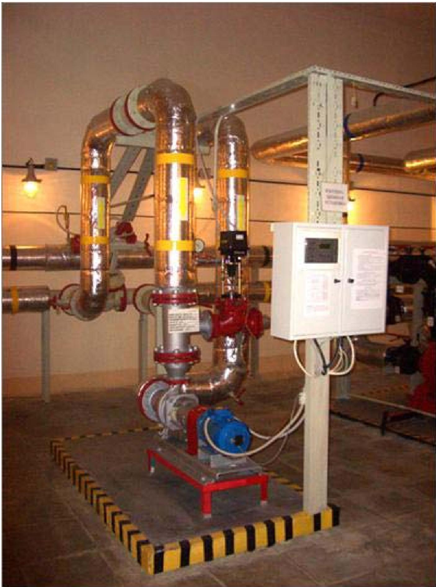
Установка для преобразования избыточного давления в системах тепло и водоснабжения
