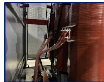
Совместно с ЭА в рамках ПП.218 разработаны КТП 6-10/0,4 кВ с полупроводниковыми устройствами регулирования выходного напряжения трансформаторов под нагрузкой (ПУРНТ)
