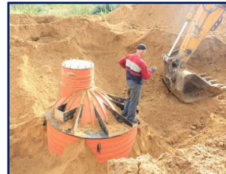
По заказу ПАО «Россети Ленэнерго» произведена разработка и ОПЭ модульной системы заглубленного исполнения с силовыми выключателями для КЛ 6-10 кВ
