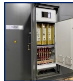
Совместно с ЭА в рамках ПП.218 разработаны КТП 6-10/0,4 кВ с полупроводниковыми устройствами регулирования выходного напряжения трансформаторов под нагрузкой (ПУРНТ)
