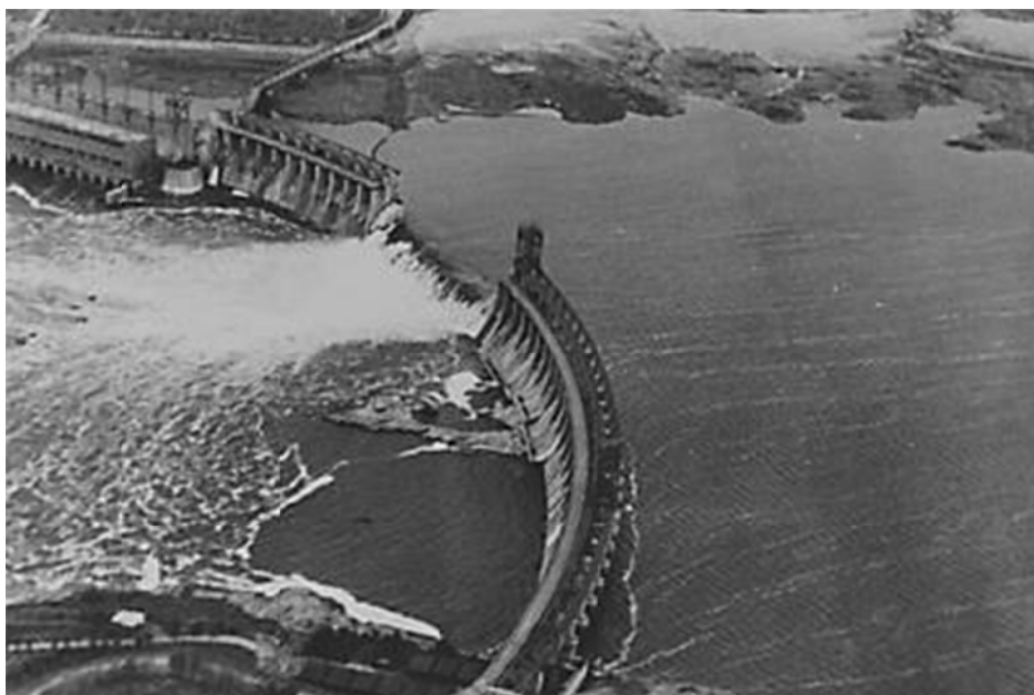
Рис. 1. ДнепроГЭС после взрыва. Август 1941 г.
